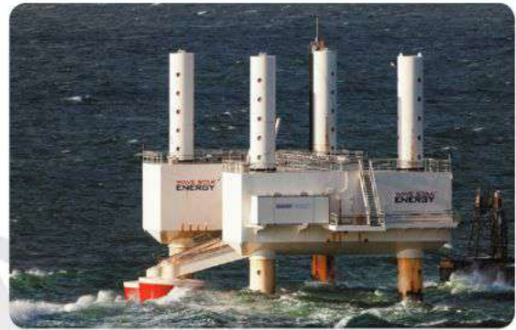
Hình 14.5. Hệ thống chuyển đổi năng lượng từ sóng biển thành năng lượng điện được lắp đặt tại Đan Mạch
