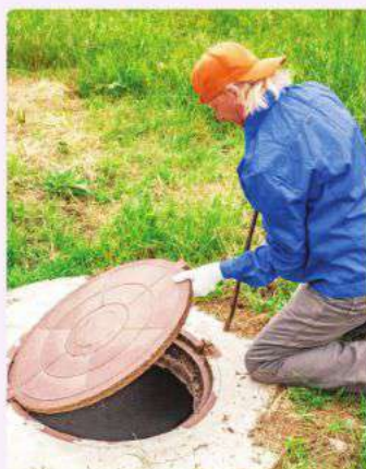
Hình 32.7. Một hố gas vừa được mở nắp
