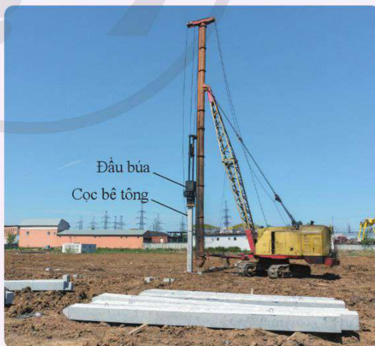
Hình 2.5. Búa máy đóng cọc
