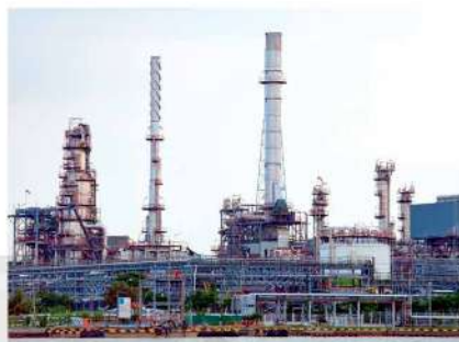
▲ Nhà máy lọc dầu
