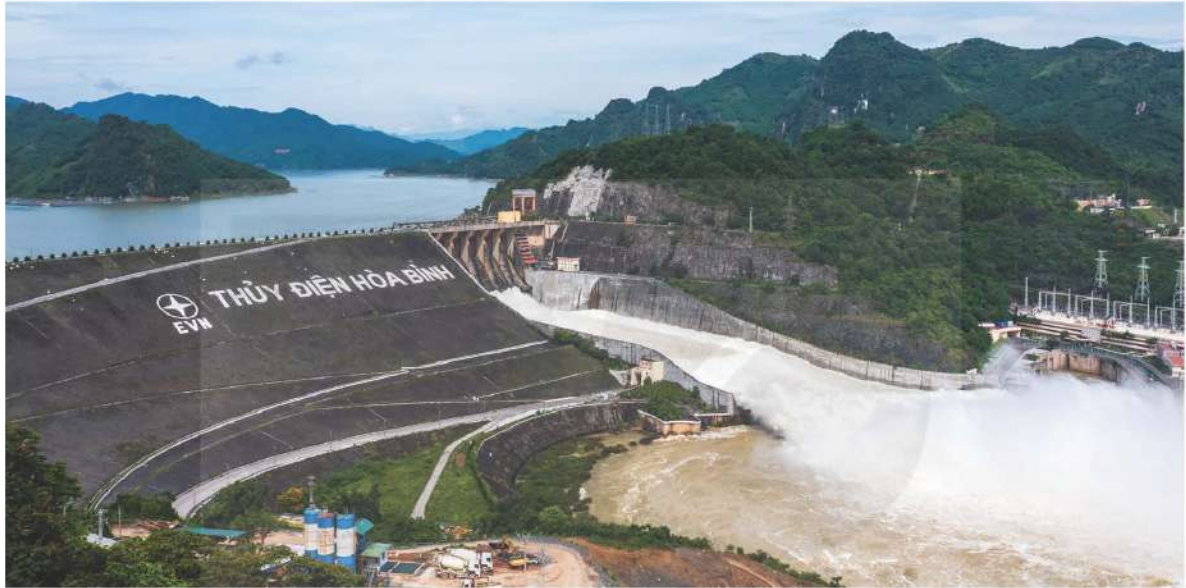
Hình 17.5 Nhà máy thủy điện Hoà Bình
