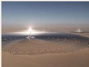
b) Nhà máy nhiệt điện mặt trời trên sa mạc
