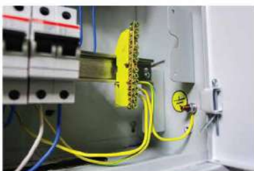
a) Nối đất hệ thống điện
