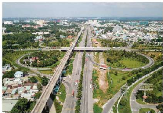
Hình 7.1. Nút giao (khác mức) Trạm 2, Thủ Đức, Thành phố Hồ Chí Minh (Ảnh: vnexpress.net)
