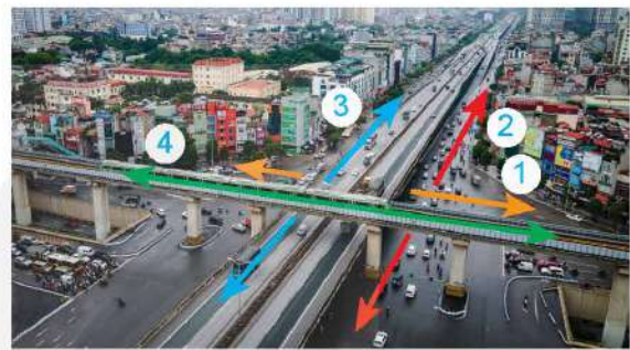
Hình 4.13. Tuyến đường bộ (1, 2), tuyến đường vành đai trên cao (3), tuyến đường sắt trên cao (4)
